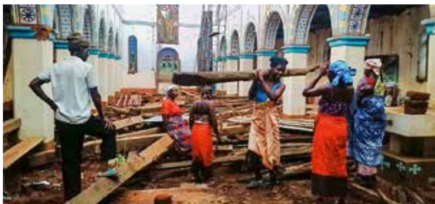
Reconstrução da igreja paroquial de São José em Mitúcue.
