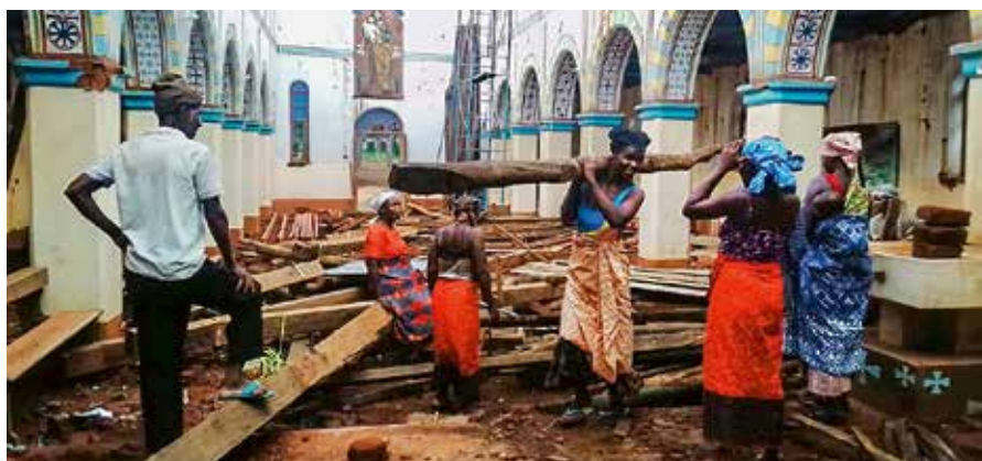
Ricostruzione della Chiesa parrocchiale di St. Josef a Mitúcue.
