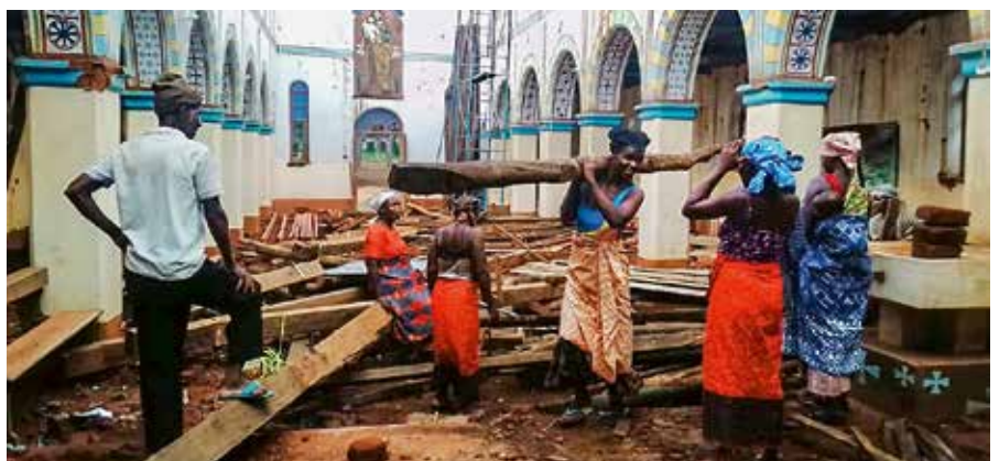
Wiederaufbau der Pfarrkirche St. Josef in Mitúcue.
